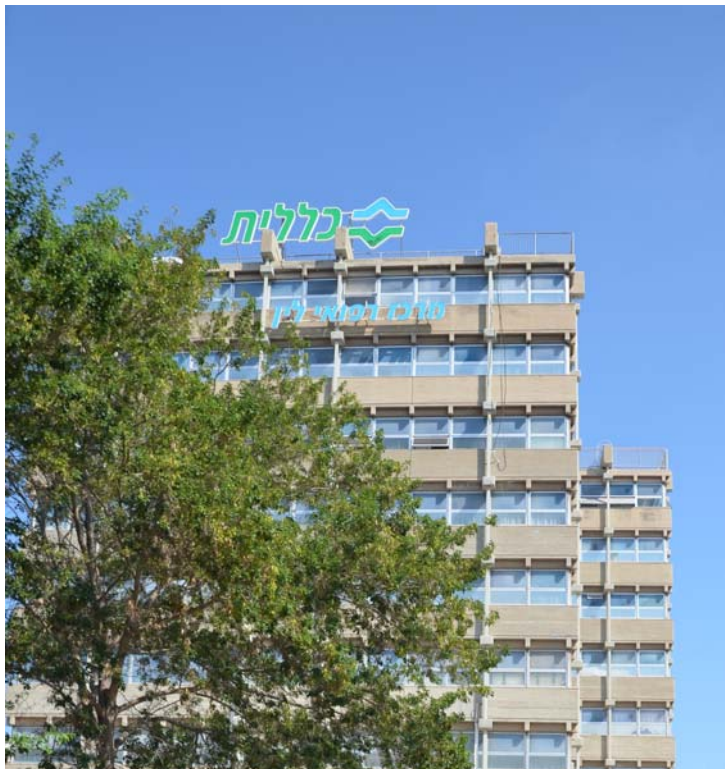
איור 1: קופת חולים לין בחיפה בתכנון רכטר זרחי פרי אדריכלים, אדריכל הפרויקט - יעקב רכטר. צילום: הדס שדר
